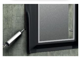
Appliquer TEROSON AD KDS FR au pistolet manuel ou pneumatique (pression d'air 0,5 à 5 bar) en cordons sur le support.
