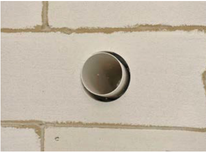
4. Instaloni elementin e fiksimit në pozicionin e duhur
