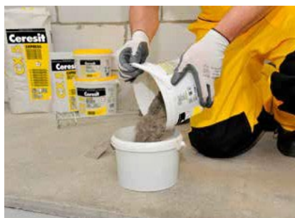
Material dodajte v vodo
