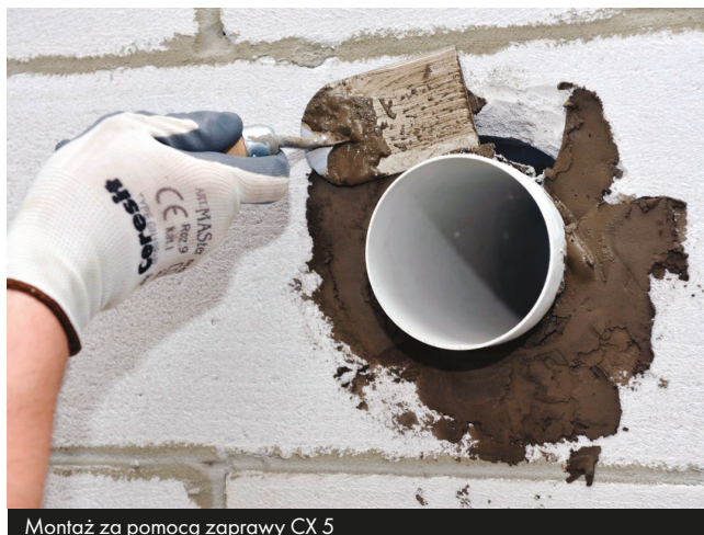
Montaż za pomocą zaprawy CX 5
