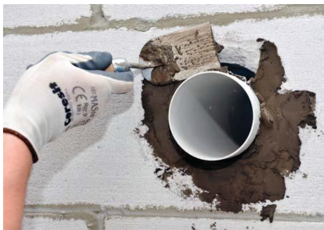
Aplink sutvirtinti mišiniu CX 5
