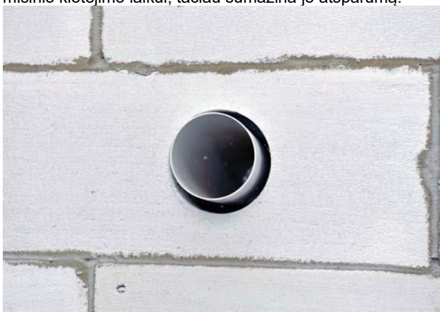
Istatyti tvirtinama elementą į reikiama padėti
