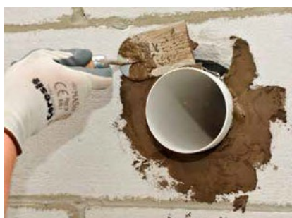
Postavljanje s Ceresit CX 5 Express brzovezujućim cementom (prethodno navlažena podloga)
