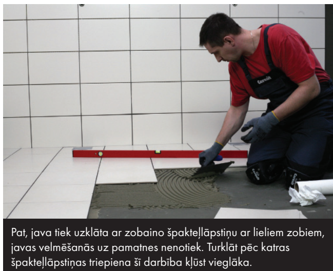
Lieliski darba parametri nodrošina CM 22 javas 100% izplūšanu zem flīzes.
