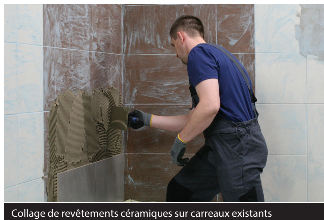
L'augmentation de la rétention d'eau dans le mortier CM 22 vous permet de choisir la bonne consistance en fonction de l'application
