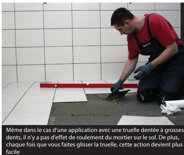
D'excellents paramètres de fonctionnement permettent d'obtenir un débit de 100 % de mortier CM 22 sous le carreau
