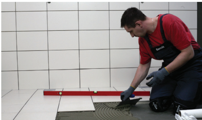
Isegi siis, kui segu pealekandmine toimub suure hammastikuga segukammil abil, puudub segu voolamine mööda aluspinda. Peale selle muutub toiming kergemaks iga kord, kui segukammiga üle aluspinda tõmmatakse.
