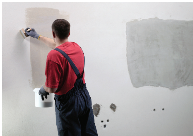
Gruntowanie podłoży nasiąkliwych przy użyciu preparatu gruntującego CT 17
