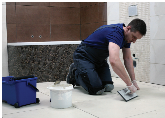
Fugowanie możliwe jest już po 24 godz., a na ścianach po 8 godz.
