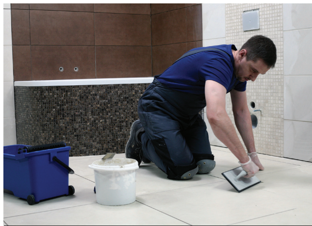
Le jointoiment est possible après 24 heures et sur les murs après 8 heures
