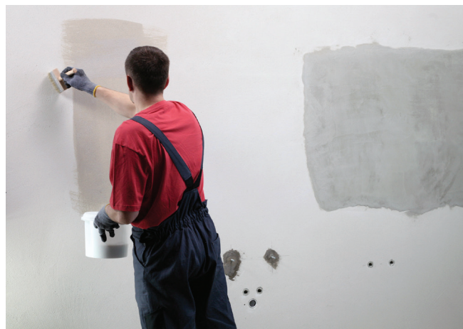
Apprêtage des substrats absorbants avec l'apprêt CT 17
