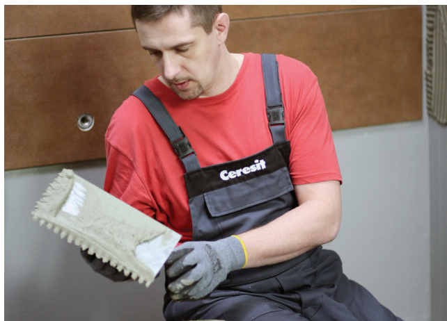
Le mortier doit être étalé sur le sol avec une truelle avec des dents sélectionnées de manière appropriée. Plus la taille des carreaux est grande, plus la dimension de la truelle dentée est grande.
