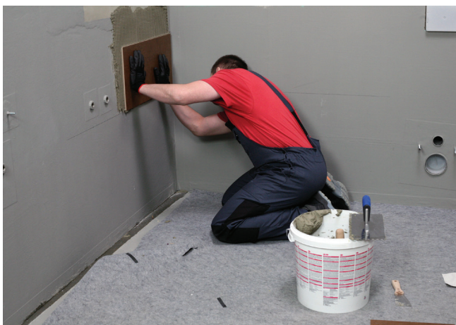
Dans le cas de surfaces verticales, il n'est pas nécessaire d'utiliser par exemple des bandes de départ en raison de l'absence de ruissellement
