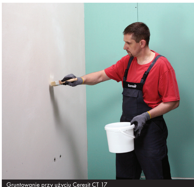
Gruntowanie przy użyciu Ceresit CT 17
