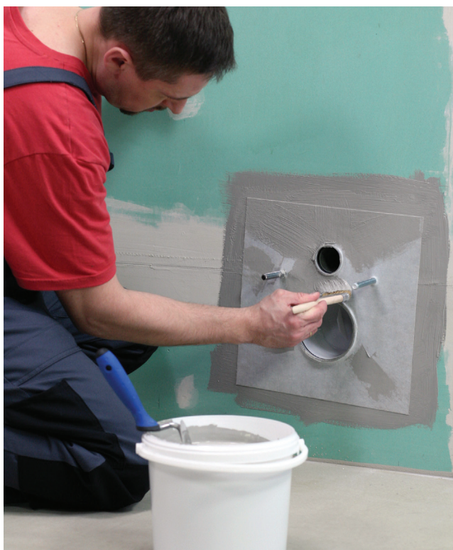
Wklejanie taśmy uszczelniającej lub fizełiny technicznej o gramaturze max. 60 g/m 2 na przejściach rur instalacyjnych
