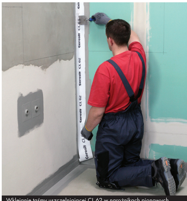
Wklejanie taśmy uszczelniającej CL 62 w narożnikach pionowych.
