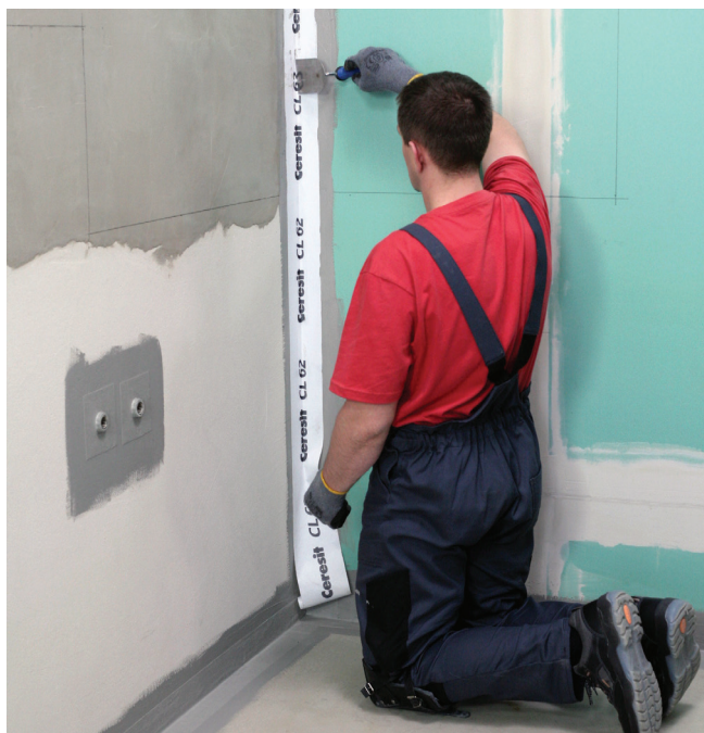
Collage du ruban d'étanchéité CL 62 dans les coins verticaux.
