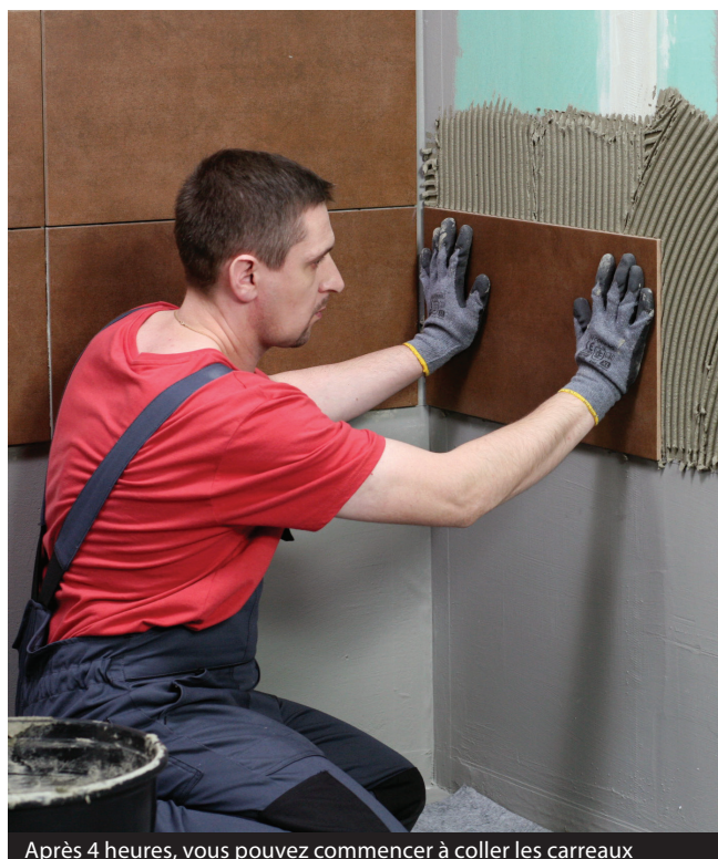
Après 4 heures, vous pouvez commencer à coller les carreaux
