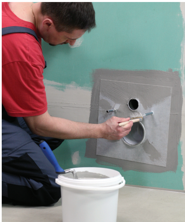
Collage d'un ruban d'étanchéité ou d'une doublure technique avec un poids max. de 60 g/m 2 aux passages des tuyauteries d'installation
