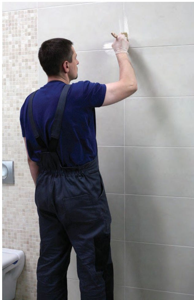
Šuvi papildus var aizsargāt ar impregnēšanas līdzekli Ceresit CT 10.
