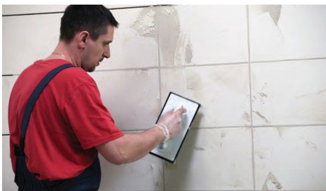
Šuves starp flīzēm ar CE 40 javu jāaizpilda precīzi.
