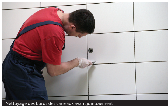
Nettoyage des bords des carreaux avant jointoiment
