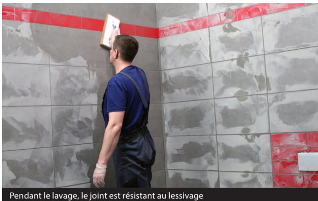
Pendant le lavage, le joint est résistant au lessivage
